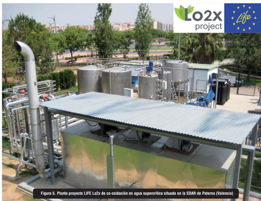
Figura 5. Planta proyecto LIFE Lo2x de co-oxidación en agua supercrítica situada en la EDAR de Paterna (Valencia)
